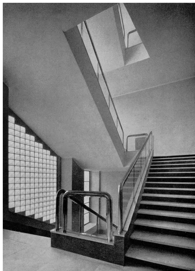
Fig. 10 - Carlo Vannoni, particolare della scala principale , 1935 ( «Architettura» , XIII, 1935, p. 17).
