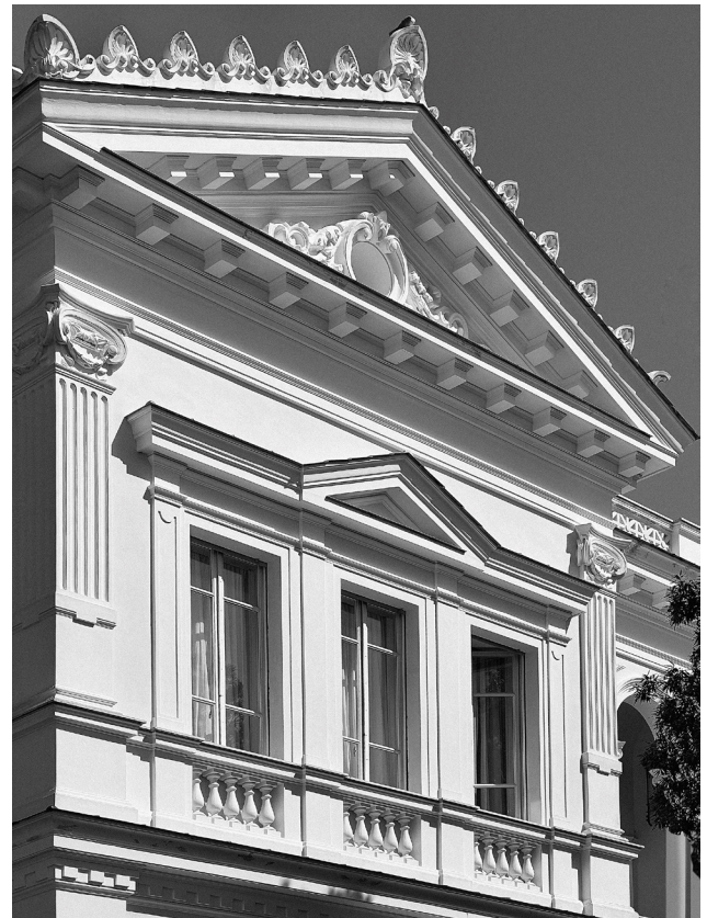
Fig. 14 - Gaeta, Villa Marina, dettaglio del prospetto sud (foto dell'autore, 2023).
